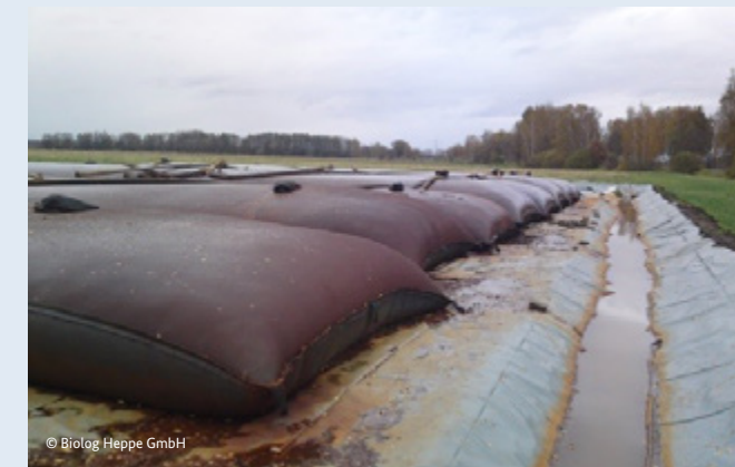
Ferosan Entwässerung in Geotubes
