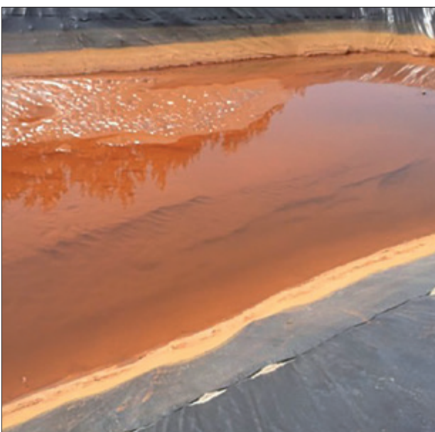
Abb. 1: Entwässerung in Absetzbecken (© Biolog Heppe GmbH)
