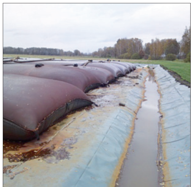
Abb. 2: Entwässerung in geotextilen Schläuchen (© Biolog Heppe GmbH)
